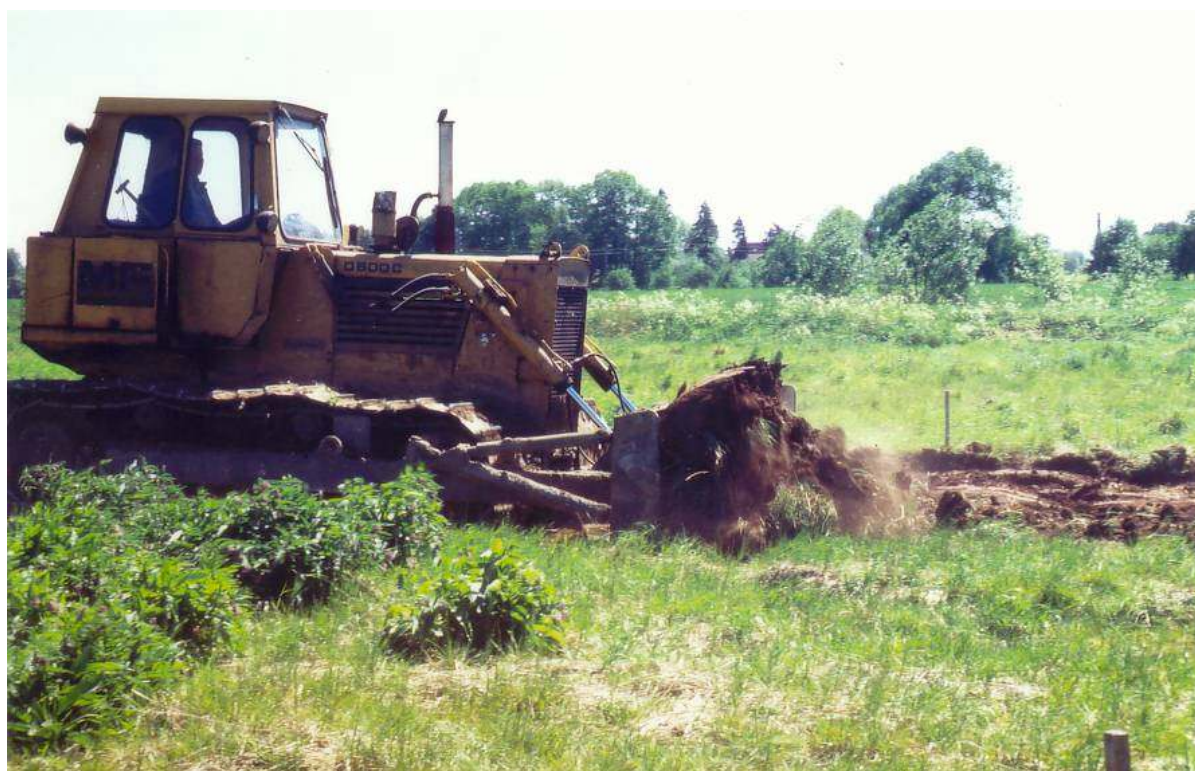
Beginn der Bauarbeiten für das Feuchtbiotop am 22. Mai 1989
